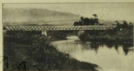
Figuur 16. Vakwerk wandbrug over de Kroëng Lam Temot in de berglijn bij K.M. 56 100 . (3 overspanningen van 25 M.)
