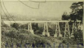
Figuur 17. Viaduct op pendelpijlers in de berglijn in een helling van 30‰ met een totale lengte van 115.5 M. (7 volle liggerbruggen van 16.500 M.)
