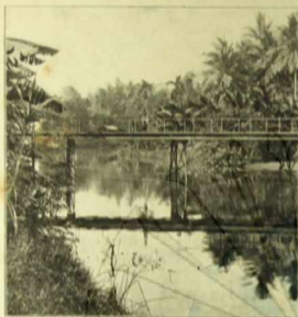
Figuur 24. Schroefpaalbrug voor tramverkeer en gewoon verkeer.
